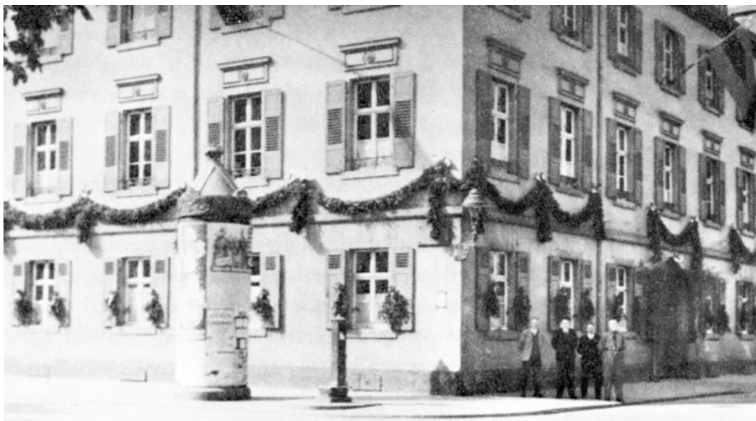
Abbildung 6: Das ehemalige Amtsgebäude in der Akademiestraße in Karlsruhe
